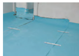
(3) Remonter de \pm 10 cm contre les murs avant de réaliser la chape
